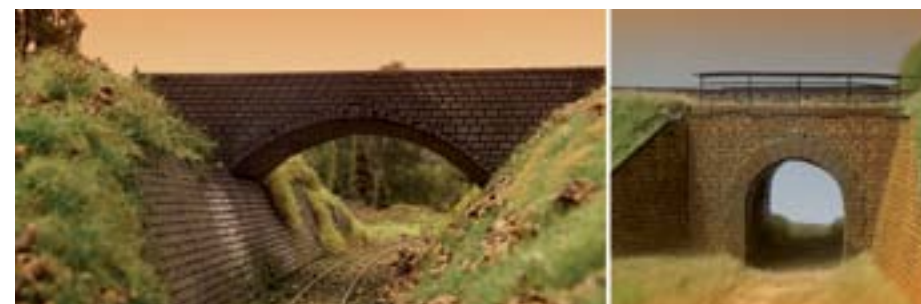
Obr. 10 Mosty a podjazdy
