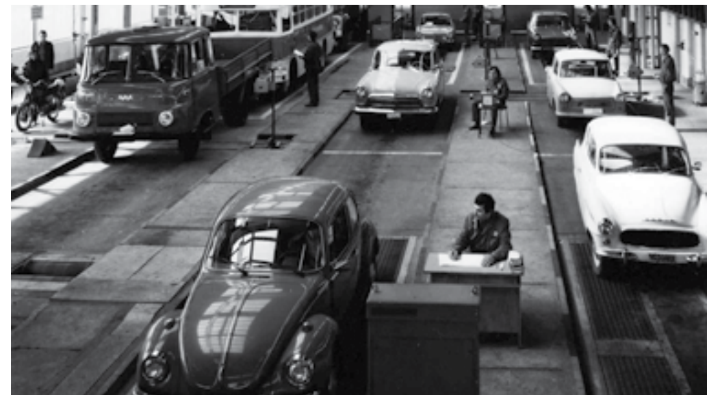
Použitie plošinových skúšobných brzd pri technickej kontrole bolo v šesťdesiatych rokoch minulého storočia pomerne rozšírené
