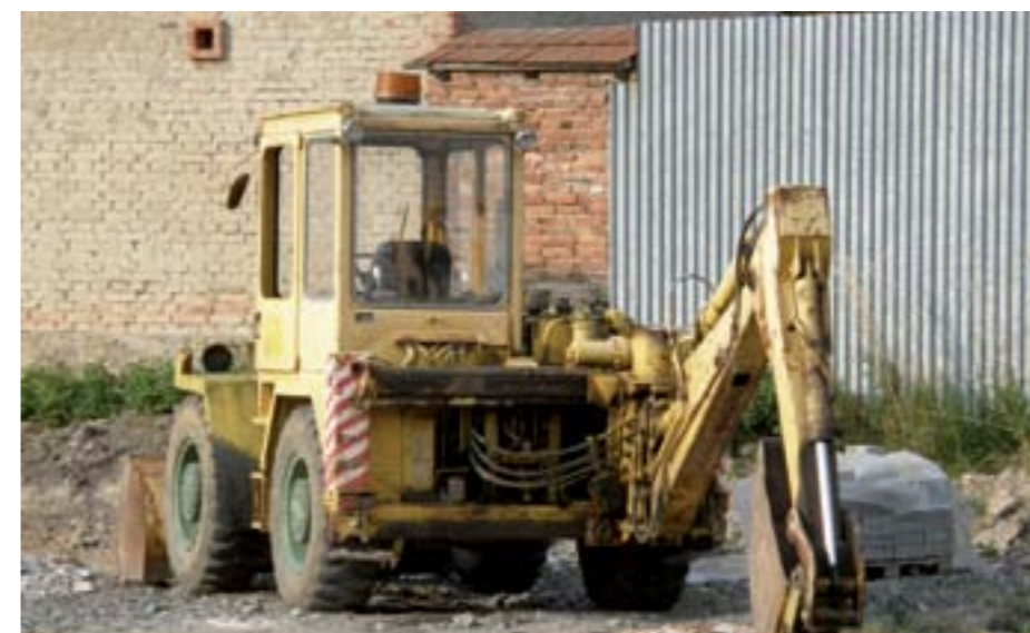
So strojmi UZS 050 sa môžeme dodnes stretnúť na stavbách. V zadnej časti dominuje do strán posuvné rýpacie zariadenie
