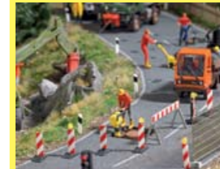
Nový asfalt vo vyčistenej cestnej jame treba utíčiť vibračnou ubíjačkou...
