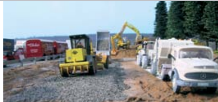
Štrk a kameň poslúžia ako prvá vrstva budúcej vozovky...
