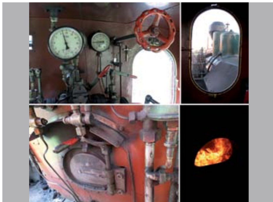
OBR. 15 STANOVIŠTE RUŠŇOVODIČA – OVLÁDACIE PRVKY A PRÍSTROJE, VÝHLAD Z RUŠŇA, KOTOL A POHLAD DO ROZKÚRENÉHO KOTLA (FOTO: M. FABIAN)
