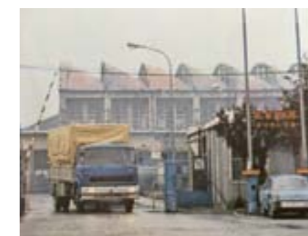
Vstup do továrne cez tzv. nákladnú vrátnicu
