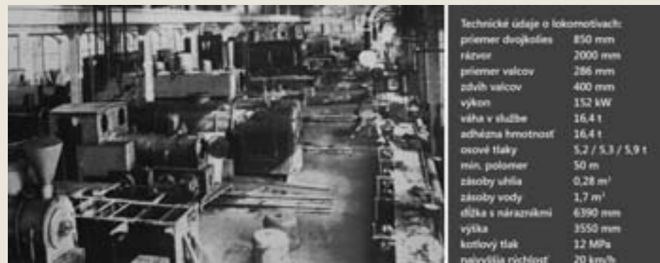
OBR. 1 VÝROBA LOKOMOTÍV V TOVÁRNI HAGANS V ERFURTE A TECHNICKÉ ÚDAJE RUŠŇOV [3]
