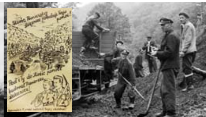
OBR. 5 PROPAGÁCIA STAVBY TRATE A SAMOTNÁ PRÁCA NA STAVBE [4]
