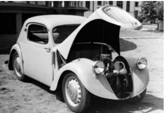
Štvortaktný vzduchom chladený vidlicový dvojvalec SV pred prednou nápravou je originálnou konštrukciou ŠKODA. Z objemu 844 cm 3 dával výkon 15 k (11 kW), poháňal zadné koliesá. ŠKODA SAGITTA vážiaca iba 580 kg jazdila až 70 km/h
