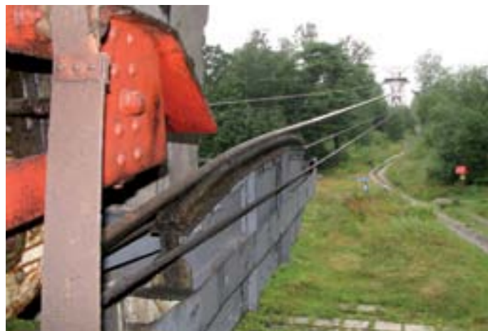
Obr. 4 Uloženie nosného a 2 ťažných lán (foto: M. Fabian)
