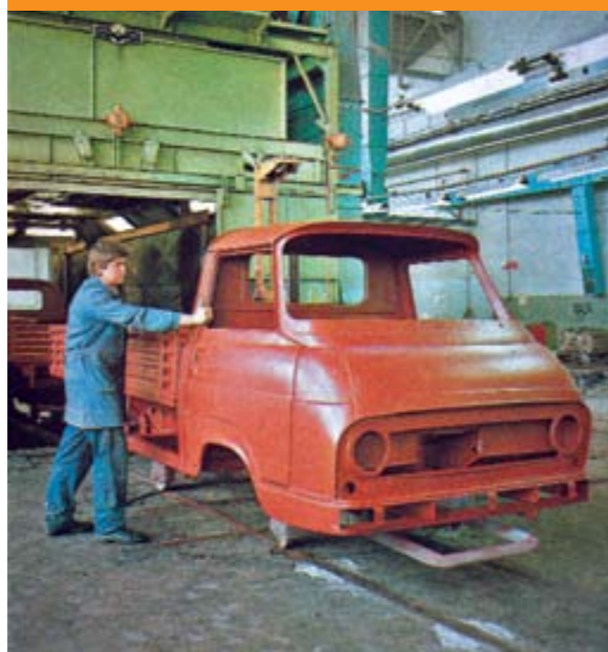
Od roku 1973 pribudla výroba karosérií a lakovnía, začala montáž vozidla (foto: Dagmar Veliká)
