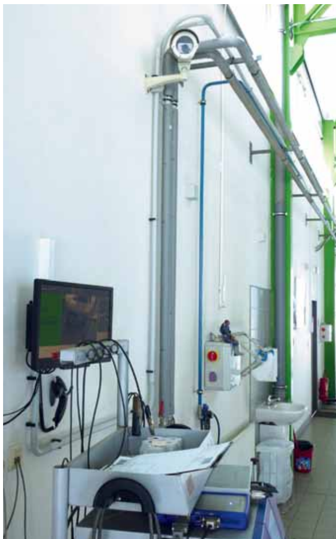
Kamera na začiatku kontrolnej linky STK, ktorá snímá vozidlo s jeho evidenčným číslom a terminál so zariadením na čítanie čiarového kódu.
