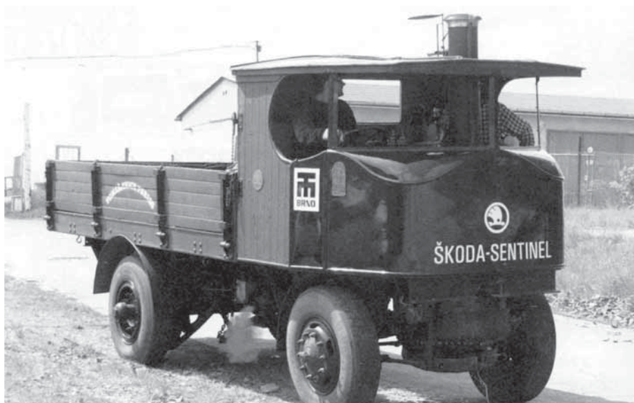
Obr. 2: Nákladné automobily Škoda –Sentinel používali ešte dvojvalcový parný stroj s výkonom 51,4 kW – paru pripravoval rúrkový parný kotol vykurovaný pevným palivom, ktorého kontrola podliehala osobitnému režimu
