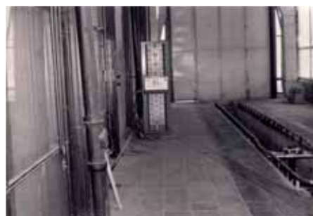
Obr. 2b: Časť kontrolnej linky STK pre nákladné automobily s valcovou skúšobnou brzdou
