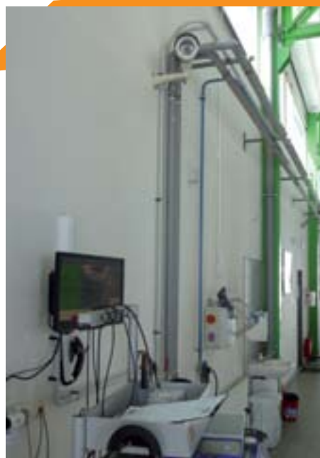
▲ Obr. 1: Pohľad na kameru na začiatku kontrolnej linky STK, ktorá sníma vozidlo s jeho evidenčným číslom a terminál so zariadením na čítanie čiarového kódu
