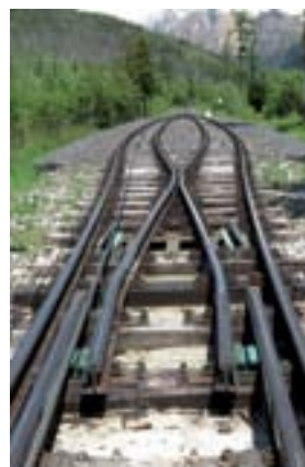
OBR. 13 VODIACE KLDKY LANA PRIAMEHO ÚSEKU TRATE (VĽAVO) A VODIACE KLDKY NA ABTOVEJ VÝHYBNÍ (VPRAVO) (FOTO: M. FABIAN)
