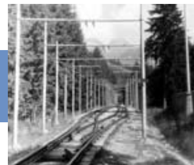
OBR. 6 STĹPY A TROLEJE ZABEZPEČOVACIEHO A DORO- ZUMIEVACIEHO ZARIADENIA DO ROKU 1987 [4]
