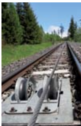
OBR. 13 VODIACE KLDKY LANA PRIAMEHO ÚSEKU TRATE (VĽAVO) A VODIACE KLDKY NA ABTOVEJ VÝHYBNÍ (VPRAVO) (FOTO: M. FABIAN)
