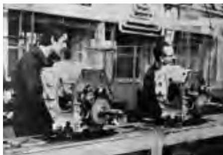
Montáž podskupín prevodoviek v Považských strojárňach na vzácnej dobovej fotografii
