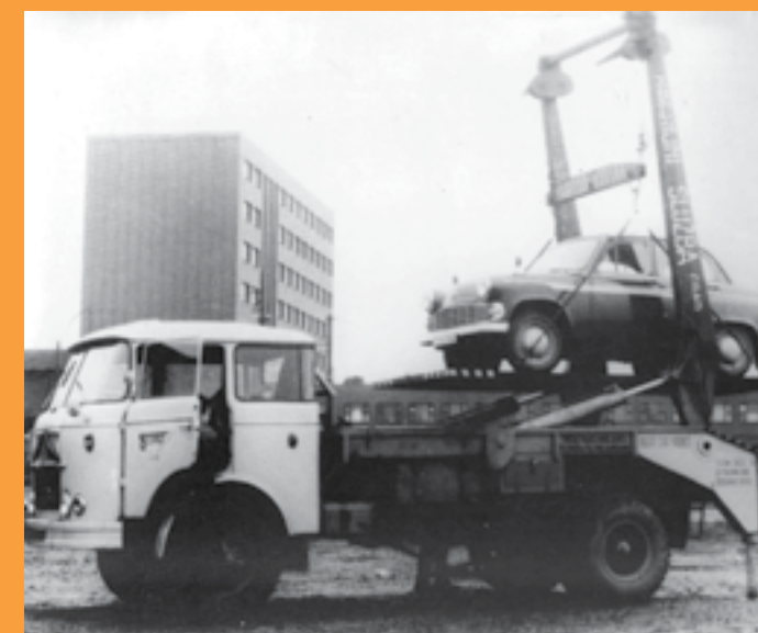
NOSIČ KONTAJNEROV NA PODVOZKU S-706RT SLÚŽIL AJ AKO ODŤAHOVKA
