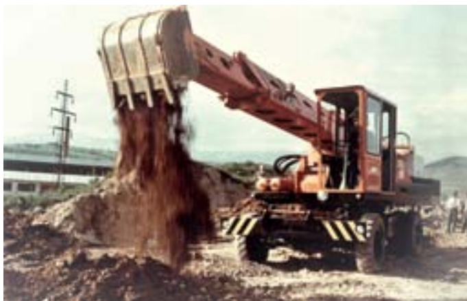
▲ V polovici šesťdesiatych rokov bol predstavený nový typ univerzálného zemného stroja SATUR s hydraulicky ovládaným výsuvným ramenom
