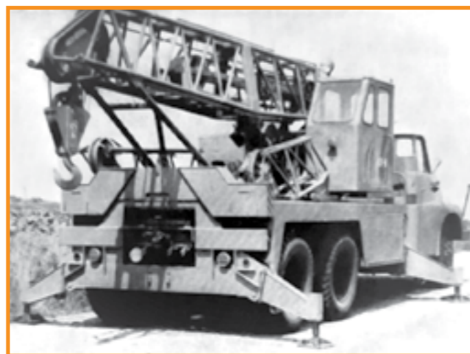
▲ AV 08 konštrukčne vychádzal z typu AB 063. Nadstavba však bola umiestnená na opačnej strane za kabínou podvozku, skrátenej výložník bol v transportnej polohe otočený smerom dozadu
