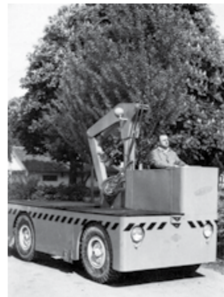
▲ Takmer neznáma špeciálna aplikácia hydraulické ruky MARP BJH 222 na samostatnom podvozku
