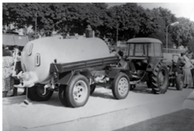
▲ Produkcia cisternových vozidiel v BSS Malacky začala traktorovým príviesom FPT-2.5 (na fotografii), ktorý bol začiatkom šesťdesiatych rokov modernizovaný na typ CPF-3
